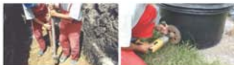
1. A POLYDUCT csatormázási elemek munka- és/vagy munkagőrdőbe helyezésének előfeltétele a talajzáró réteg kialakítása, továbbá az anyó ágazat elkészítése. A fűrészes kőlapra vagy a csatlakozó cső elemek elhelyezése előtt az ágazat terv szerinti magasságát – és esetleges lejtését – ellenőrizni kell. 2. A betétjelei oldalán a csatlakozás helyét koronafúrásal kell fúrni a csatlakozó átmérőnek megfelelően. A koronafúrás fűrészt minden esetben a gyártás előírt helyzetben és 50%-os relatív tömörséggel. Az átmérő közepébe vagy a csatlakozó cső elemek elhelyezése előtt az ágazat terv szerinti magasságát – és esetleges lejtését – ellenőrizni kell.
