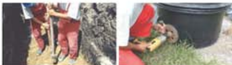
1. A POLYDUCT csatormázási elemek munkái nagyobb vagy munkagödrökbe helyezése előtt a talajvízmentes munkát, továbbá az anyó ágazat elválasztásának felületét és 50%-os relatív tömörséggel. Az ártalmak ellen-súlyozására az elmúlt 40 évben a műanyag – KPE, PVC, PP és ÜPE – vagy a kőanyag csövek alkalmazása került előtérbe. A fenti anyagokkal – elfogadható árszinten – megvalósíthatók a cement kőanyagú hagyományos csatormázási anyagoknál kétszeres szulfátkorróziós jelenségek. A szennyvizekkel kapcsolatban, az előzőekben már vizólt kedvezőtlen változások mellett növekedett a talaj- és a talajvíz szennyezettsége. A két hatás együttesen a cement kőanyagú csatormcsövek és aknák gyors tönkremenetelét eredményezte.
