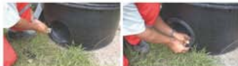
3. A kész keresztmetszet szelést előzetesen meg kell vizsgálni, hogy a felület a gumgyűrű helyezéséhez kifogástalan állapotba kerüljön. A szelést követően a felületet mentes, tiszta ronggal tisztítani illetve pontbarátítani is kell. 4. A kész akna csatlakozó gumgyűrűt az előkészített csatlakozó felületre kell helyezni. A kész és betét felületen egyaránt ellenőrizni kell az egyenes lefutást.
