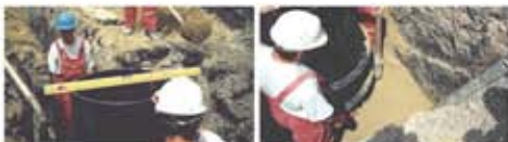
6. Az előkészített anyó ágazatra leeresztett felületet vízszintre kell állítani. Ezt a műveletet minden további elem behelyezése után elvégezni kell. Különös gondot kell fordítani arra – a megfelelő stabilitás érdekében – hogy a követ kialakítás előtt, részben elválasztó résszel is kellő mértékben tömörítést kell végezni. Ehhez célszerű fűtődeszt beton alkalmazni.
