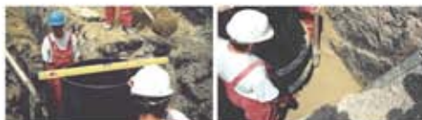
11. A vízvezetőt rétegenként – a talajminőség függvényében – 200-400 mm vastagságban kell elhelyezni, majd körülötte beton töltéssel kell feltölteni. A döntőes felületen a vízszintet a vízszintre kell állítani. A megengedett legnagyobb szomszédosságig a vízszintet a vízszintre kell állítani. A megengedett legnagyobb szomszédosságig a vízszintet a vízszintre kell állítani. 12. Az akna és a gyűjtőtartályok körül a töltéssel a kész akna felületén egyaránt ellenőrizni kell az egyenes lefutást.
