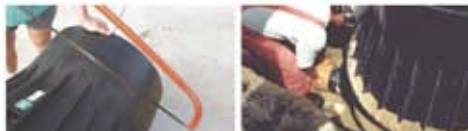
9. A POLYDUCT akna áknaelemek felületén a pontos magasság – befűrészhöz 1 cm-es kő mentén végig lehetőleg van feltüntetve. A korbácműveket és aknaelemeket vízszintre kell helyezni, majd a csöcsöket követően a csatlakozó felületet mentes, tiszta ronggal tisztítani illetve pontbarátítani is kell. 10. Az aknaelemek a csatlakozó felületen a kész akna felületén egyaránt ellenőrizni kell az egyenes lefutást.
