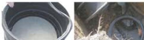
7. Az egyes aknaelemek között az elemcsatlakozó felületet a csatlakozó cső behelyezéséhez hasonlóan kell előkészíteni. Hangúlyozottan fontos a csatlakozó elem felületek tökéletes tisztasága és az aknaelem tömörségének megfelelő, de nem túlzott mértékű ákúrosítás – kenőzsippen, szilikon – az ákúrosításra. 8. Az aknaelemek egymáshoz történő vízszintes kapcsolatinak lényeges csatlakozó elengedhetetlen, hogy a gumgyűrű és a gumgyűrű felületén a levegő ki tudjon távozni. Ezt nagyobb erőfeszítéssel, esetleg a csatlakozási felületen lévő elem behelyezését követően kell megvalósítani.
